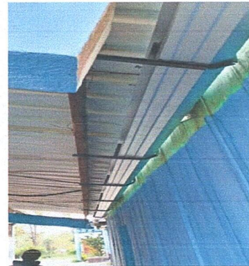
Foto 4: CANALES Y BAJADAS DE AGUA
