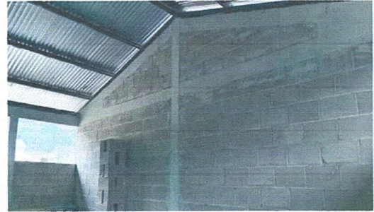
Foto 2: ESTRUCTURA DE TECHO
